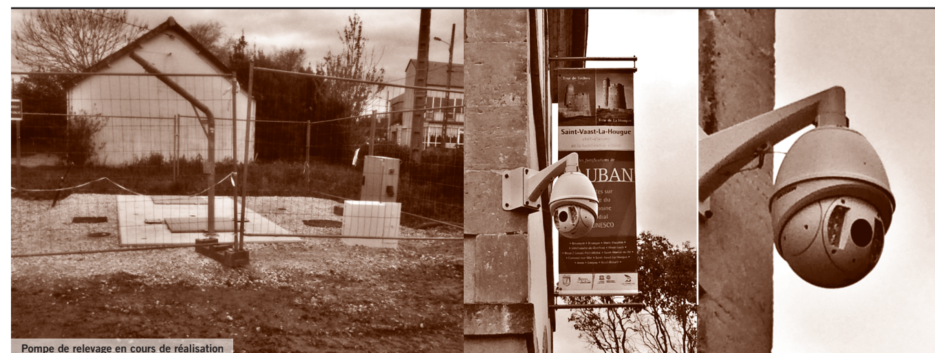
Pompe de relevage en cours de réalisation
