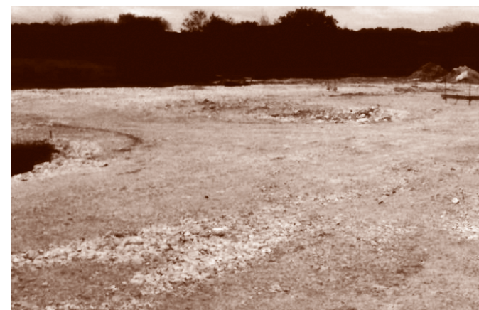
Travaux de fondation du Centre de secours achevés
