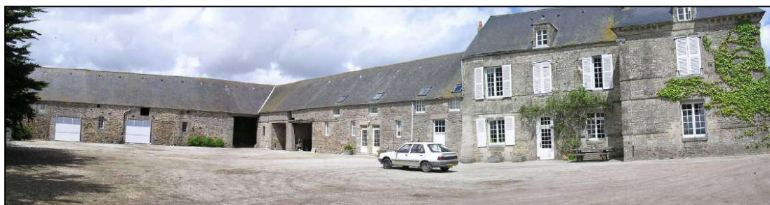
Les bâtiments de la ferme du Thot
