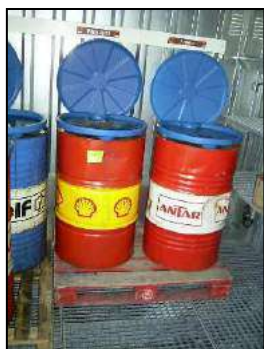
Zone de stockage des produits sur rétention
