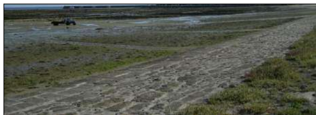
La digue du Trava Crochu
