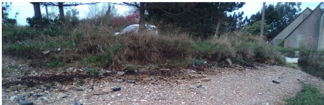
Rive droite berge
